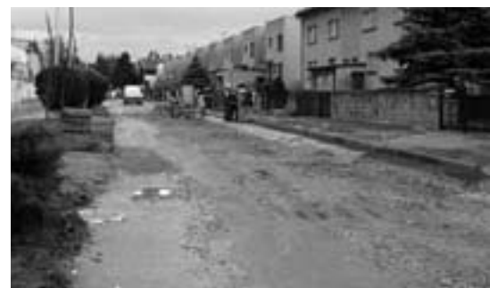
I. etapa rekonstrukce Lesní ulice
